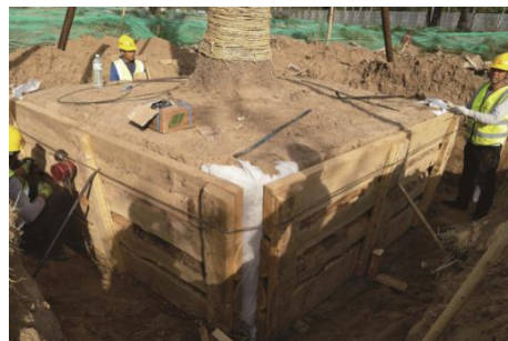
靠箱板、箱板紧固
