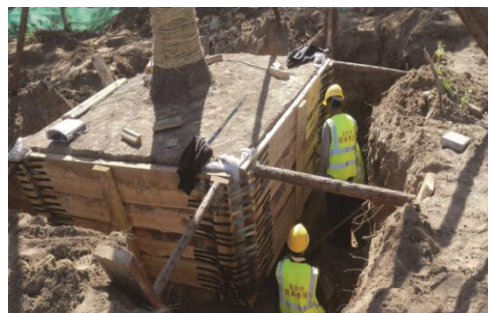
掏底、上底板 箱板紧固
