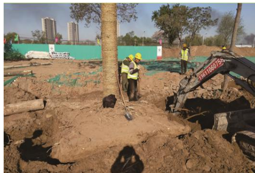
土台挖掘挖土
