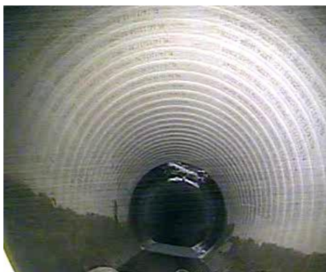
(11) 最后恢复流槽、CCTV 检测作为验收依据
