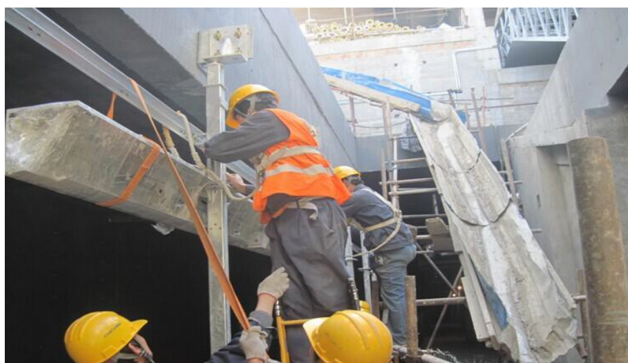
图 4-2 上部结构安装
