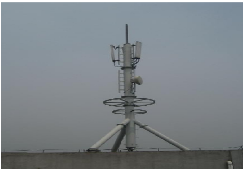
图 6-5 楼顶天线铁塔
