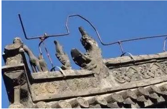
图 7-7 沿瓦坡屋脊明敷示意图
