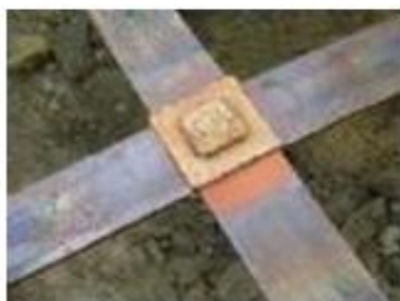
图 7-3 放热焊连接
