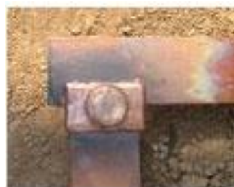
图 7-4 放热焊连接
